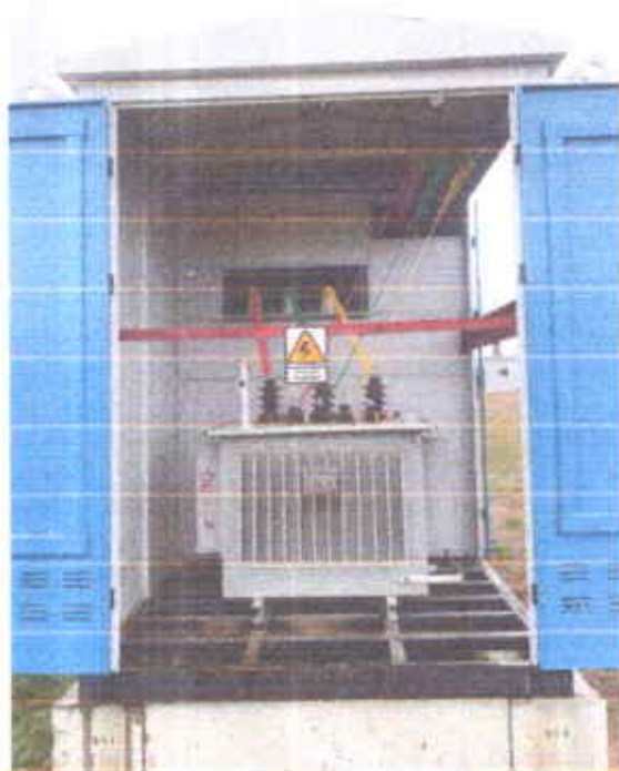
Трансформаторын хаалтанд плакат хийх
