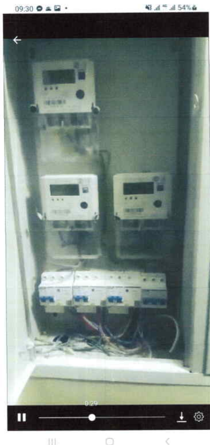
4-р давхрын айлын ерөнхий самбарт автоматыг дифференциал автоматаар сольж хийв.
