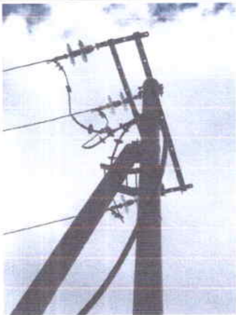
Агаарын шугамд кабель шугам холбохдоо бүрээс хуулахгүй холбох
