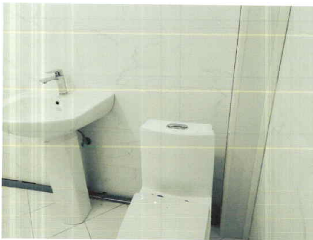
АЦӨ-ны бохир усны шугамыг хаалтаар хаасан байдал А загварын сууц 3-р давхар
