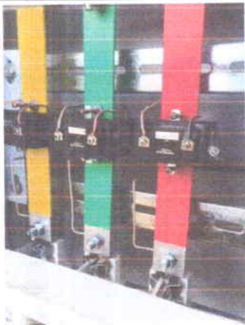
Ачаалалд тохируулан гүйдлийн трансформаторыг солиж суурьлуулах
