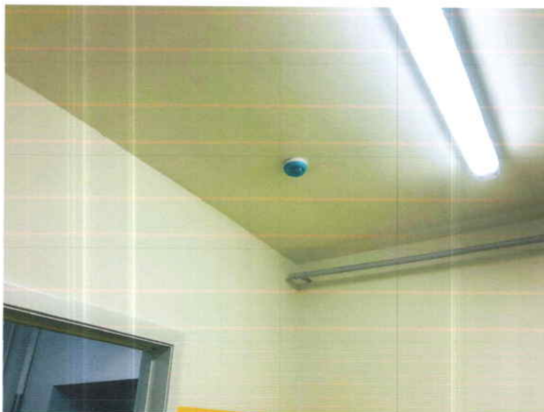
Зарим өрөөнд хийгдээгүй байсан утаа мэдрэгчийг нэмж суурьлуулсан
