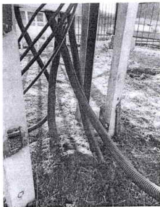
0,4кВ кабельд хамгаалалт хийсэн байдал:
