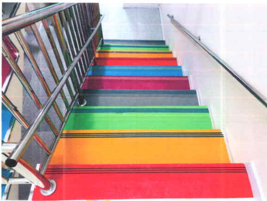
Барилгын дотор талын шатны бариул нэмэлт гагнуур хийлгэж өнгөлгөө хийсэн
