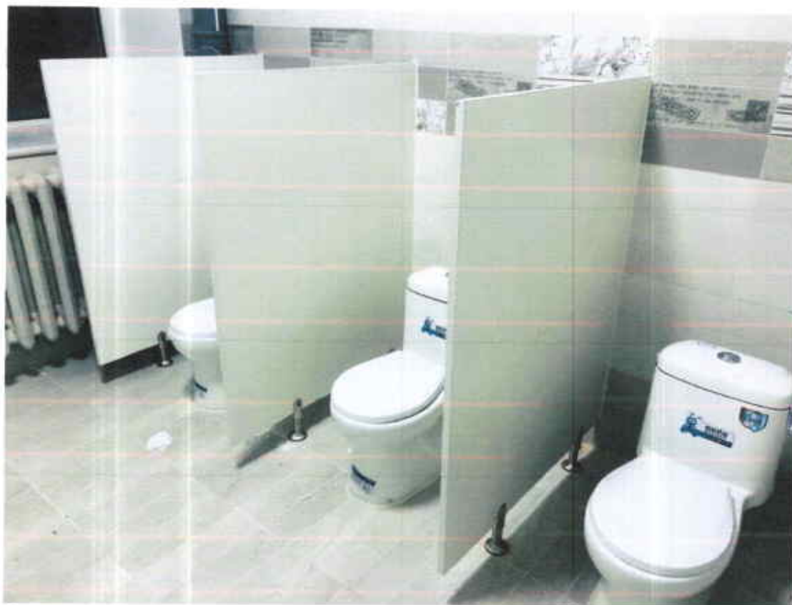
Барилгын ариун цэврийн өрөөнд суултуурын тусгаарлах хаалт хийж суурьлуулсан
