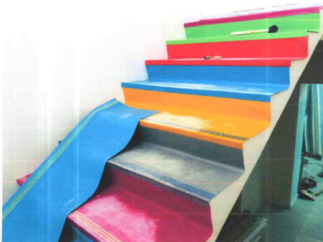
Барилгын дотор шат хүлцэх алдааг хэмжүүлж гадаргууг тэгшилсэн
