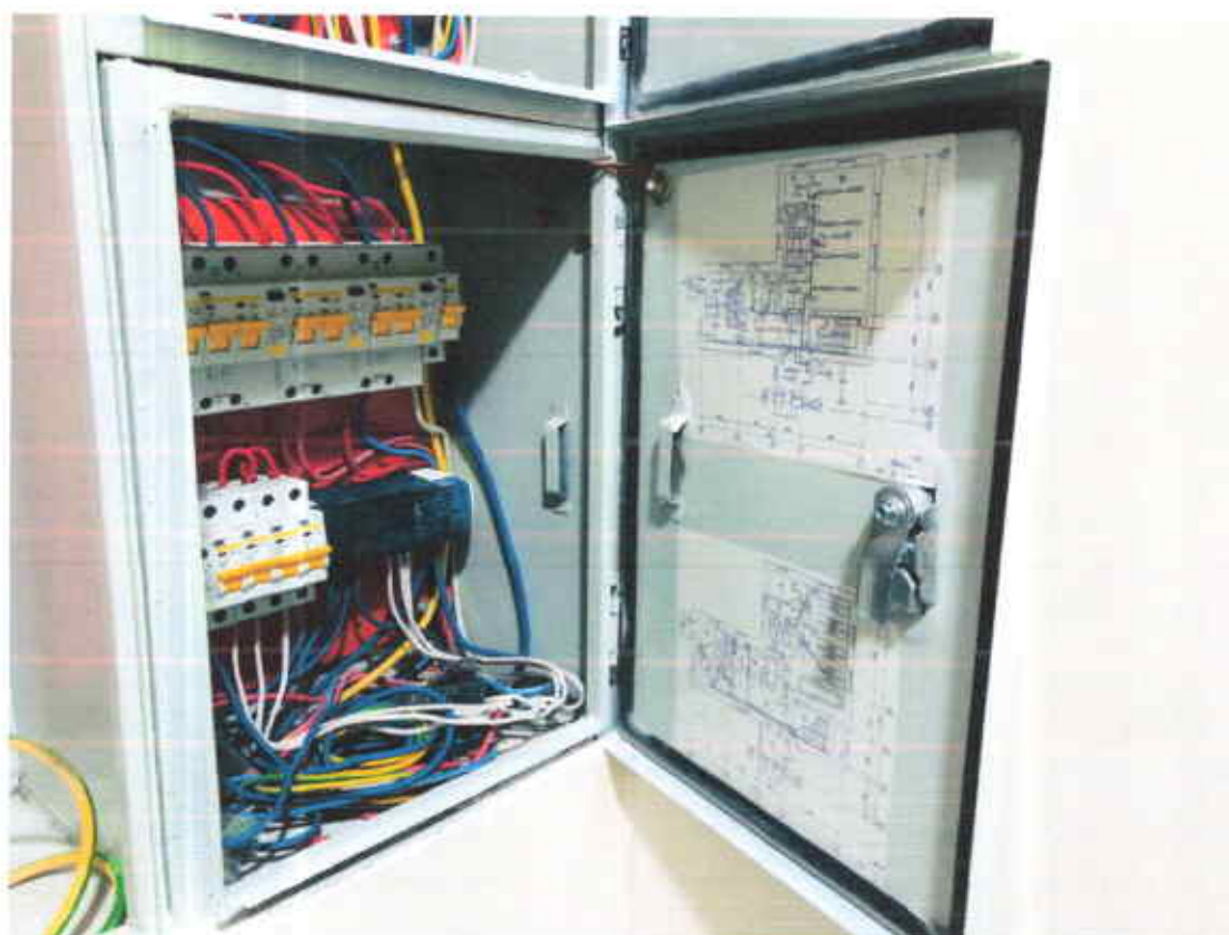
Барилгын дотор цахилгааны шийтэнд бирк хийж зааварчилгаа өгсөн
