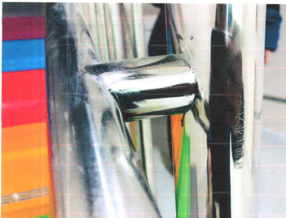
Барилгын дотор талын шатны бариул нэмэлт гагнуур хийлгэж өнгөлгөө хийсэн
