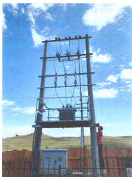
Оруулгыг давхар изоляторын холболттой болгов.
