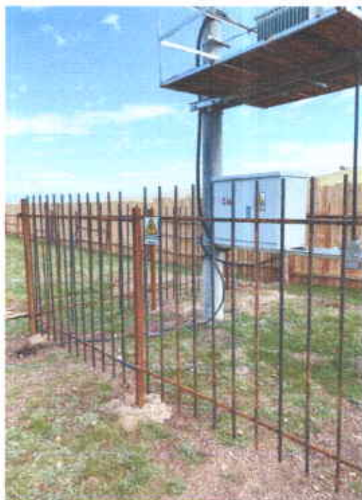
Дэд станцад хамгаалалтын хашаа, плакат бичиглэл хийсэн байдал.
