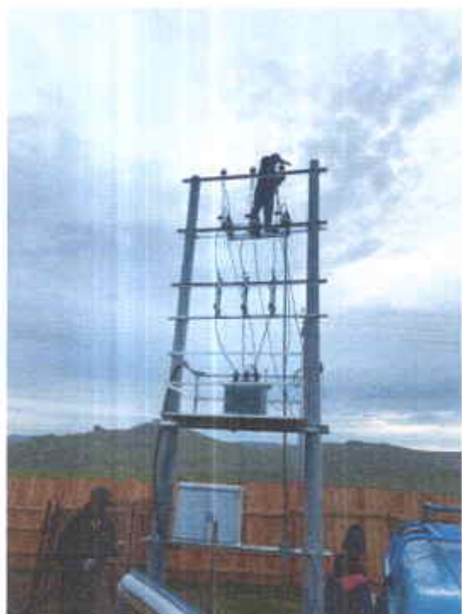
Оруулгыг давхар изоляторын холболттой болгов.
