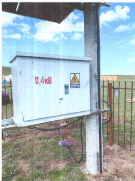
Дэд станцад хамгаалалтын хашаа, плакат бичиглэл хийсэн байдал.
