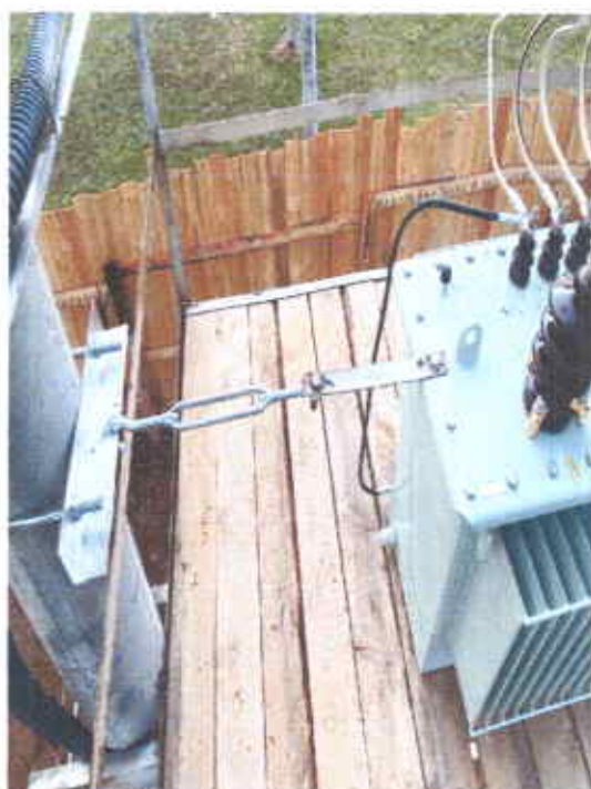
Трансформаторын суурь модонд бэхэлгээ хийж өгөв.
