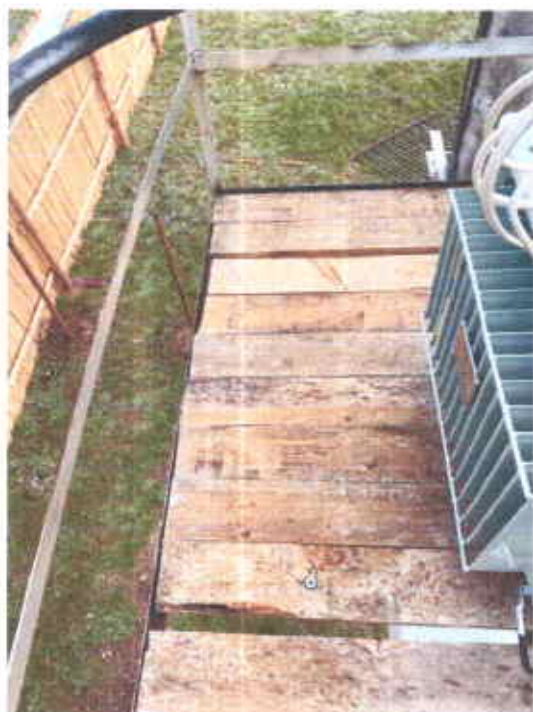
Трансформаторын суурь модонд бэхэлгээ хийж өгөв.
