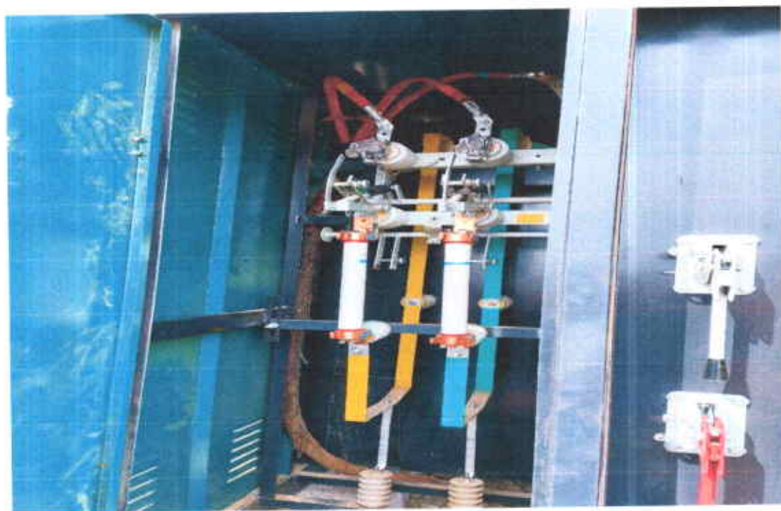
кабелийг 10 кВ талын ячейкруу оруулж холболт хийсэн.
