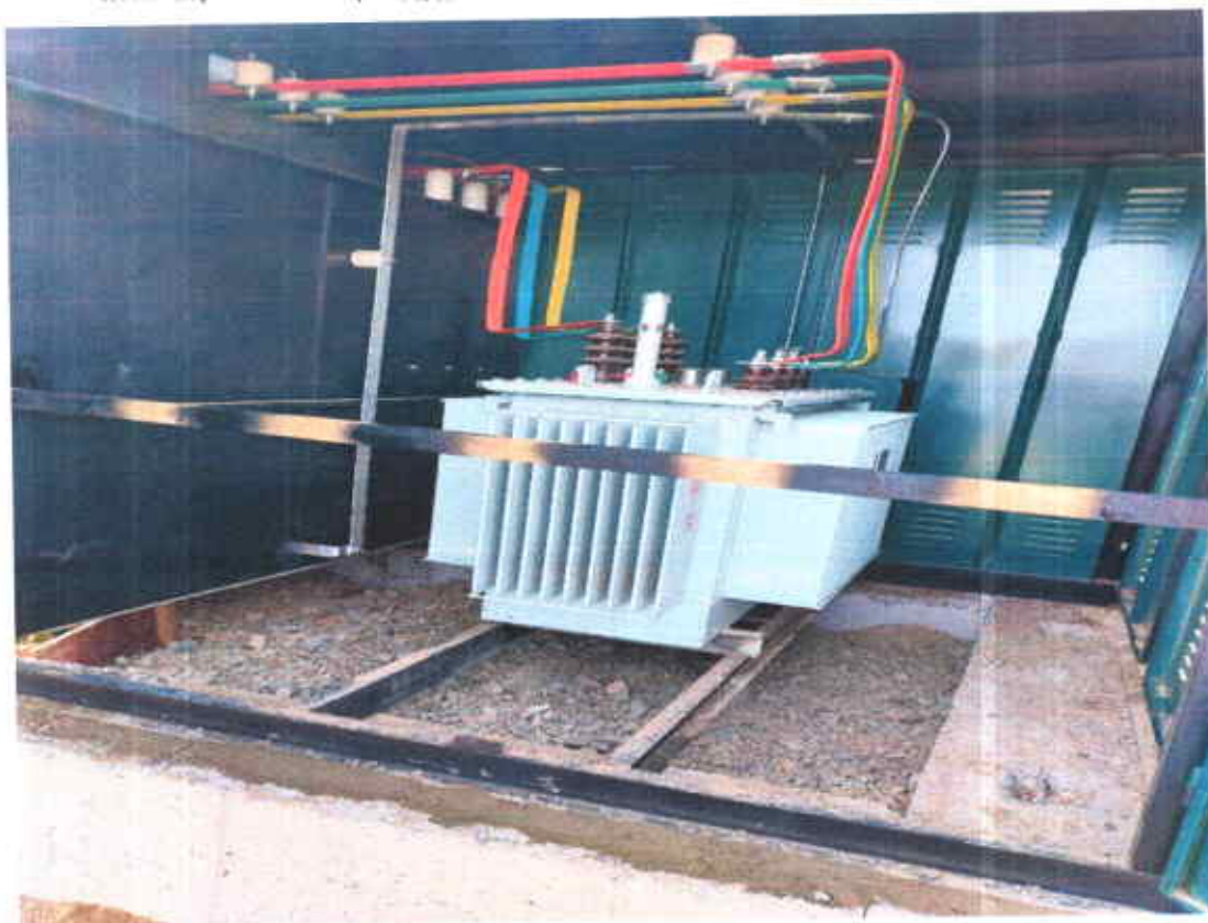
кабелийг 10 кВ талын ячейкруу оруулж холболт хийсэн.
