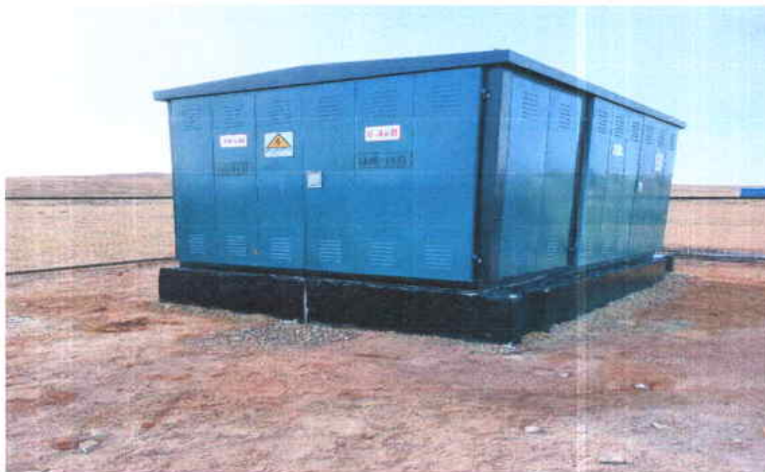
КТПн-н суурийг хулдаасан будгаар будсан байдал
