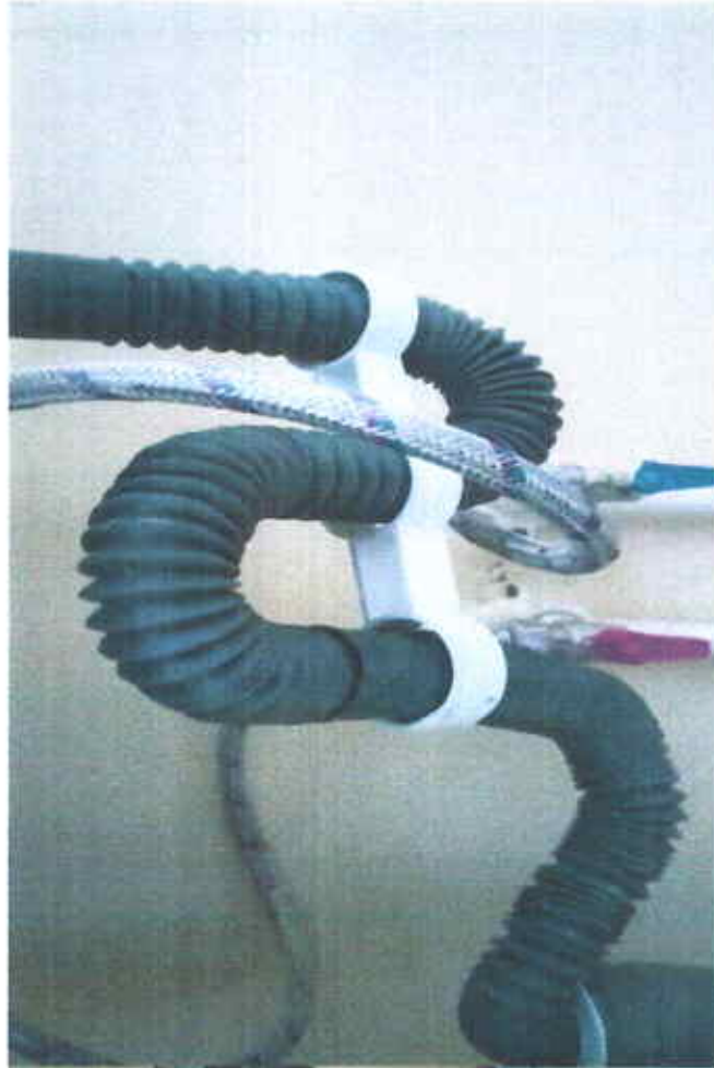
Угаалтуурын бэхэлгээг сайжруулж , усан түгжээ, жийрэг резинуудийг гүйцэтгэсэн байдал
