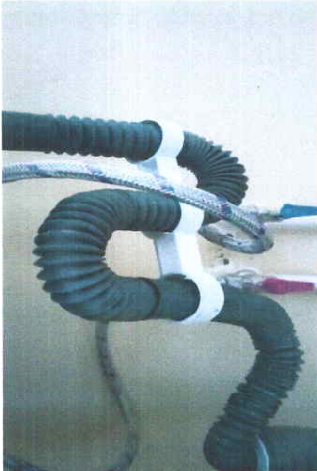
Угаалтуурын бэхэлгээг сайжруулж , усан түгжээ, жийрэг резинүүдийг гүйцэтгэсэн байдал
