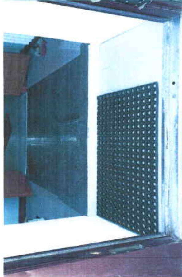
Үүдний орц гарц, 00-н өрөөний орц, гарцны хэсгийг тэгшилж, халтирч гулгахаас сэргийлсэн байдал
