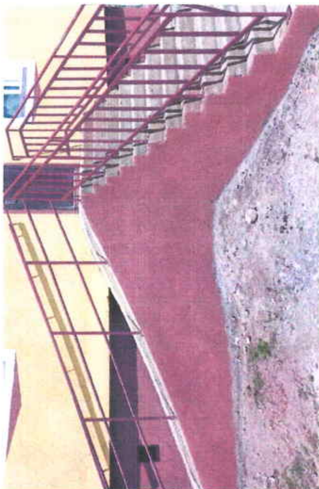
Гадна шатны хөндийг тоосгоор өрж битүүлсэн байдал
