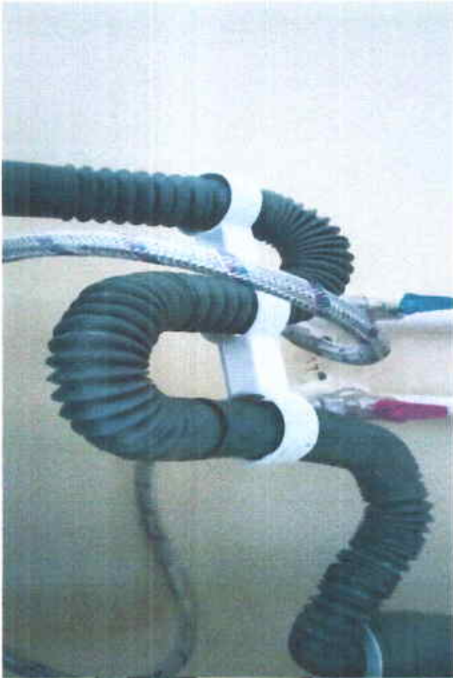
Угаалтуурын бэхлэгээг сайжруулж, усан түржээ, жийрэг резинүүдийг гүйцэтгэсэн байдал
