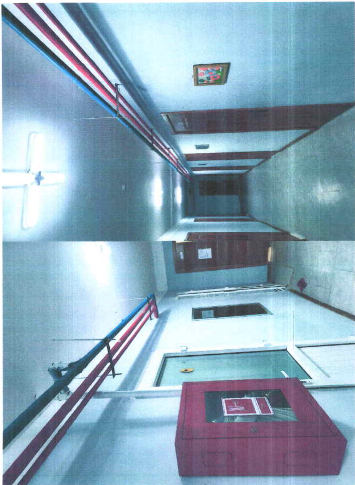
Дотуур усан хангамж өнгөөр ялгаж бүрсэн байдал
