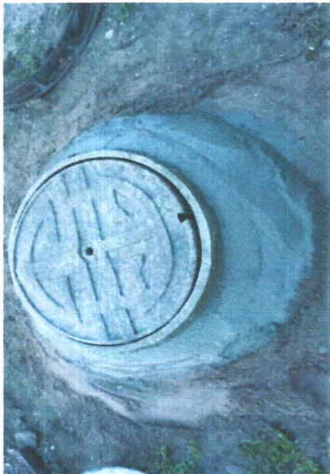
Гадна шугам хоолой, септикний таг хийсэн байдал
