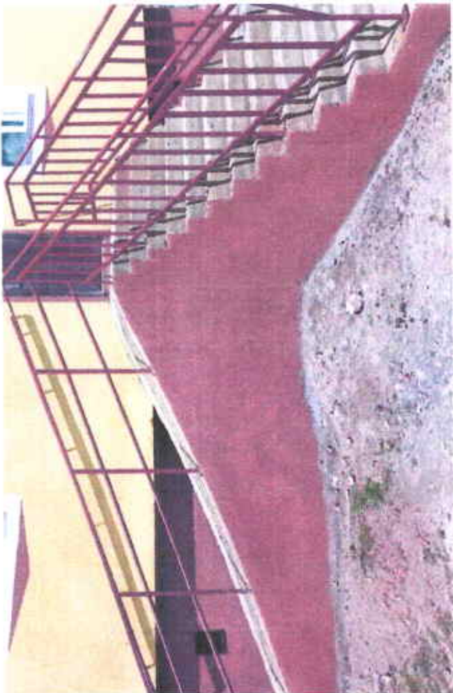
Гадна шатны хөндийг тоосгоор өрж битүүлсэн байдал
