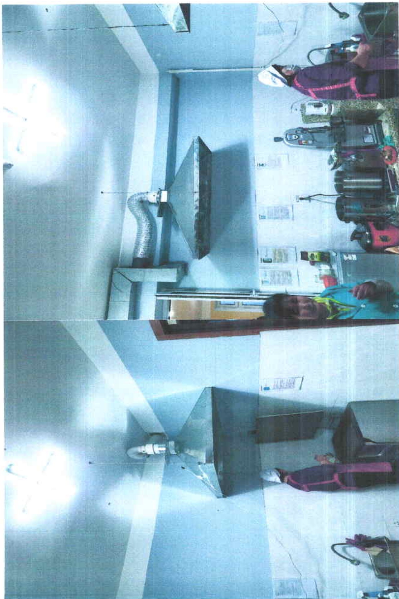
Гал тогоонд уур сорогч, агаар сорох сэнс хийсэн байдал
