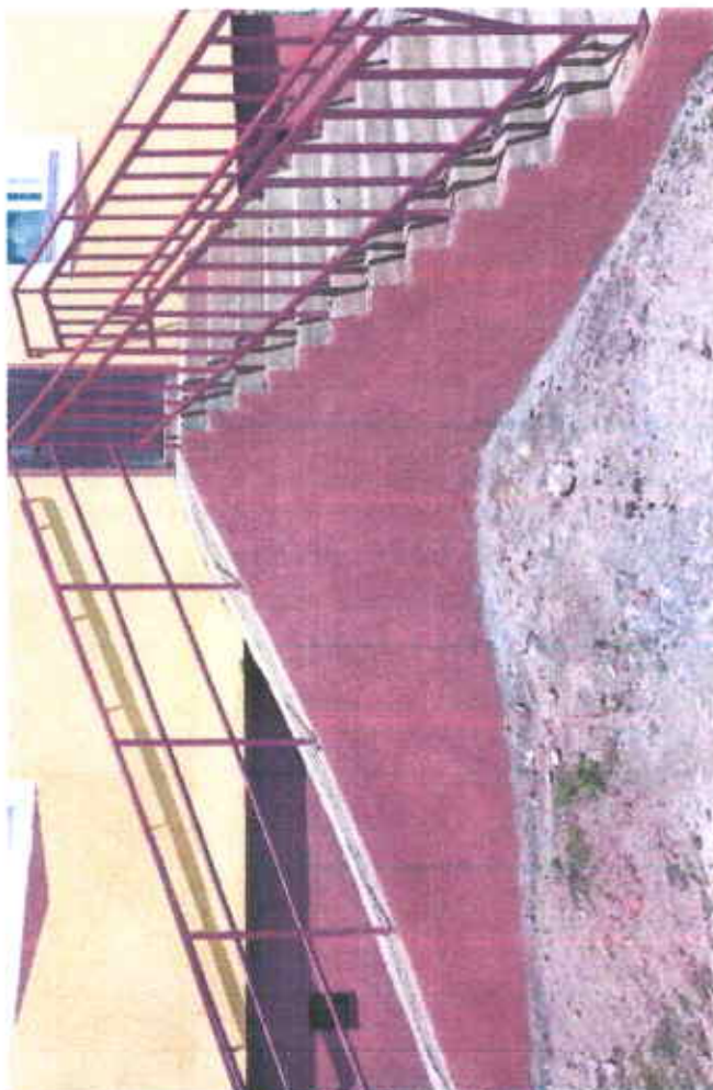
Гадна шатны хөндийг тоосгоор өрж битүүлсэн байдал
